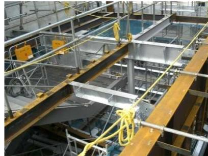
Doka-Kletterschalung hergestellt. Der äußere Gebäudeteil wird mit Stahl gebaut und dem Kern nachgezogen. Zudem werden noch in Teilen des Gebäudes Stahlbetonfertigteile als Stützen eingebaut.
