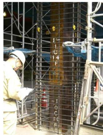
Die ersten 3 Stockwerke sind auf sehr spezielle Art und Weise gebaut. Zuerst wird ein Stahlträger eingebaut und anschließend wird dieser außen noch mit Stahlbeton verstärkt. Da die Stahlträger alleine jedoch schon tragend sind, kann der Bau oberhalb davon schon
