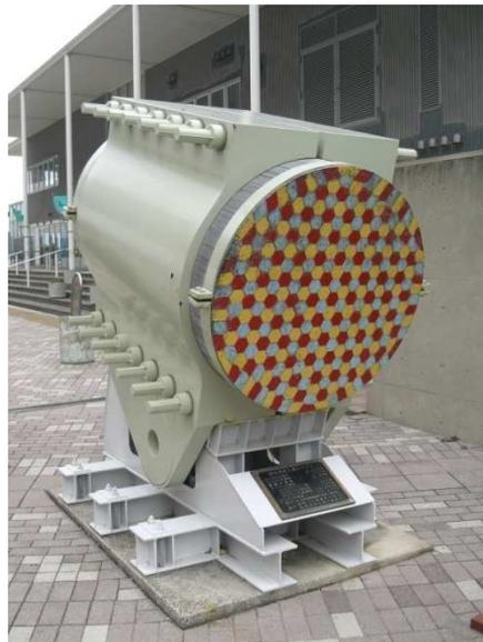
entwickeltes Gerät zu dem gesamten Stahlseil zusammen gezwirbelt sind. Dieses ist durch eine Stahlhülle und diversen Anstrichen gegen Rost geschützt. Danach wurde die Fahrbahn jeweils auf beiden Seiten der Stützen von oben verlegt um den Schiffsverkehr nicht zu behindern.
