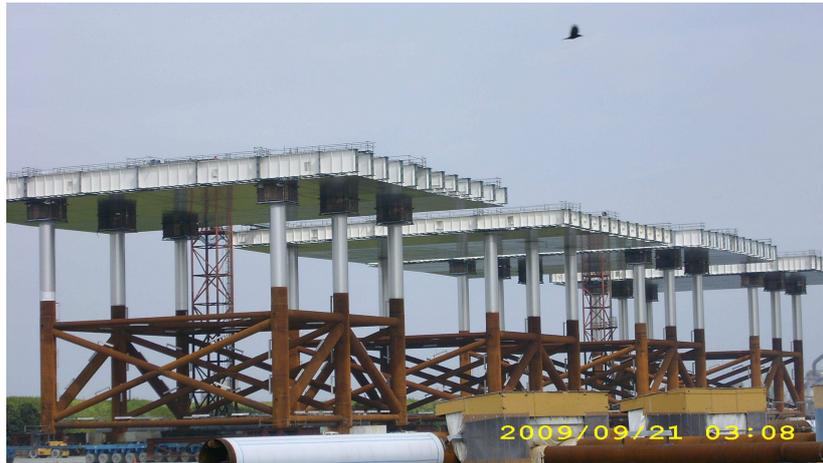
*Abb. 4: Fertige Stahlstützenelemente*
