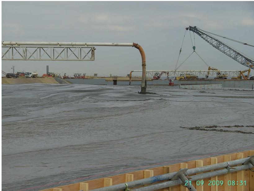
*Abb. 7: Betonieren mit SGM*
