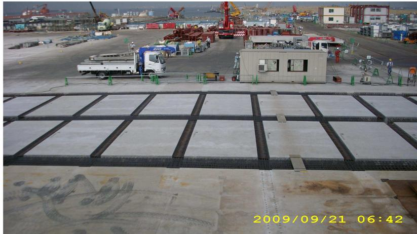
*Abb. 6: Eingesetzte Stahlbetonelemente vor dem Ausbetonieren*
