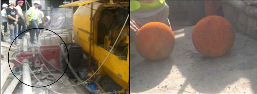
Abb. 27: Sperrschieber (li.), Schwammkugeln (re.)
