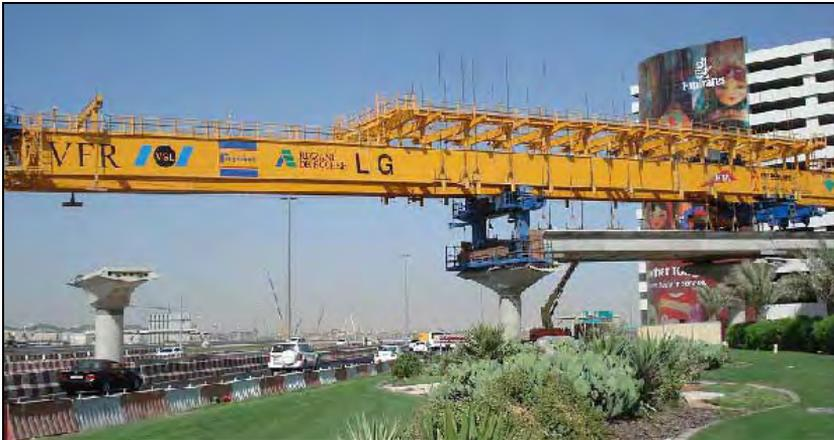
Abb. 58: Vorschubgerüst beim Einhängen der Fertigteilsegmente
