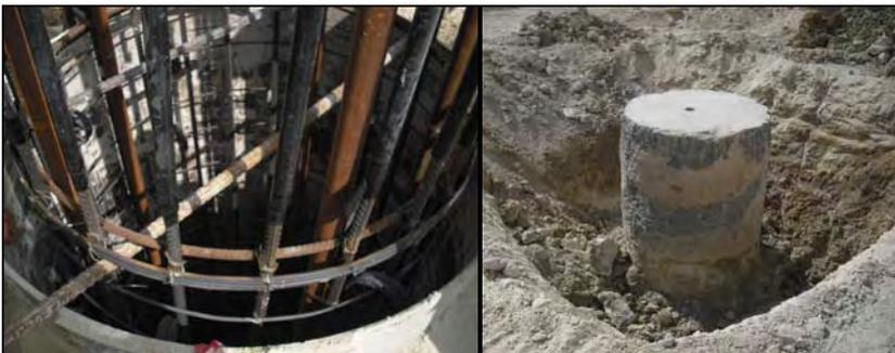
*Abb. 22: Bewehrungskorb (li.) und fertiger Bohrpfahl (re.)*
