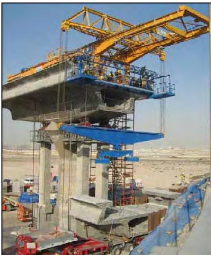
*Abb. 60: Hubkran beim Einheben eines Segments*
