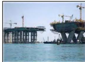
*Abb. 40: Brückenbau im Freivorbauprinzip*
