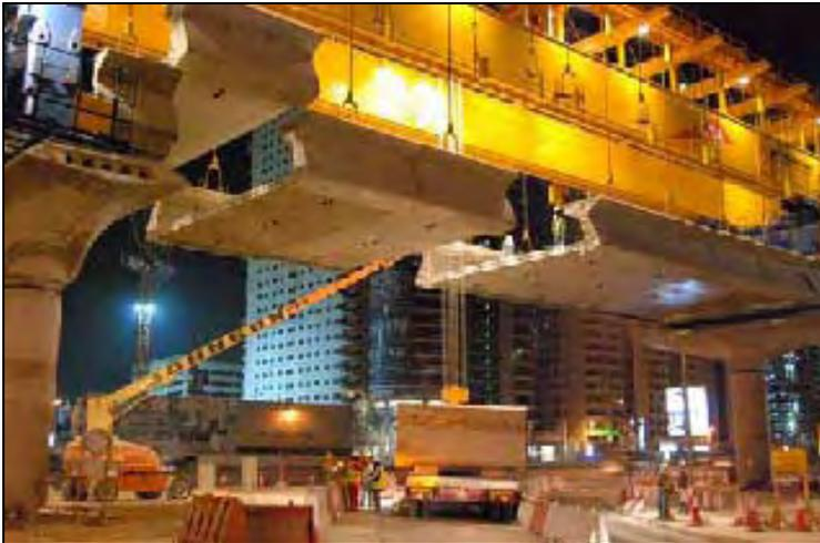
*Abb. 59: Vorschubgerüst beim Einhängen der Fertigteilsegmente*
