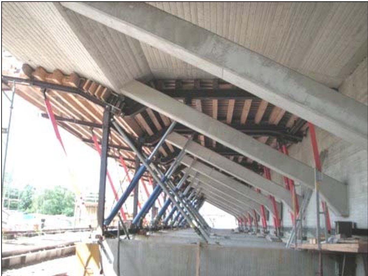
Schalung mit hydraulischen Stützen
