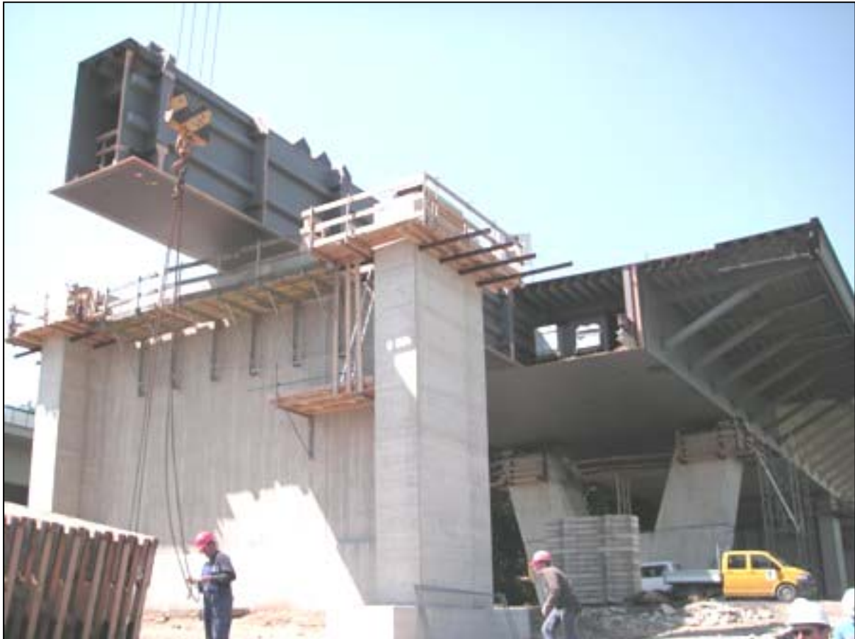
Hilfsstütze mit aufgelegtem Vorbauschnabel
