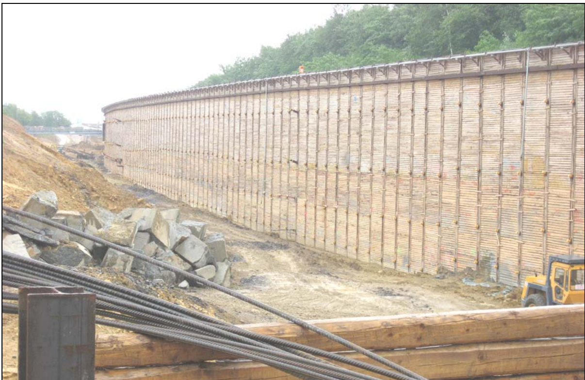
Blick auf die Trägerbohlwand
