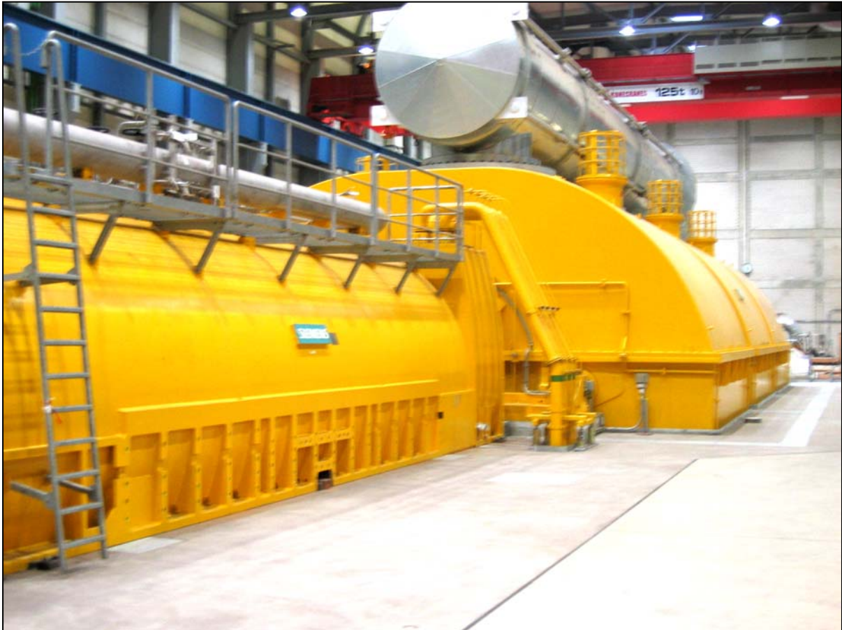
Dampfturbosatz der BoA 1
