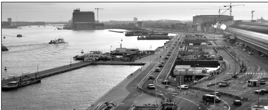
Bild 7: Foto der Nordseite (Stand 2006)
