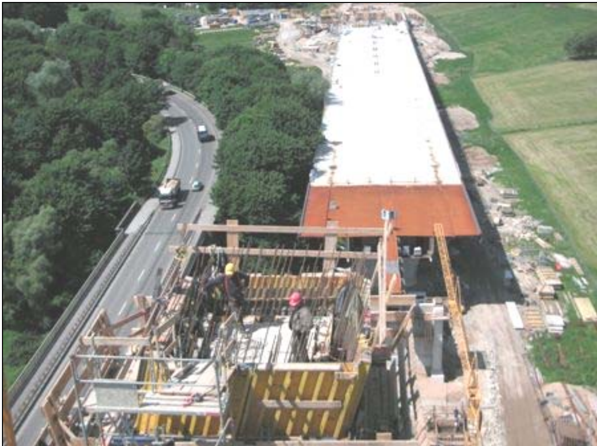
Alte Brücke – Neue Brücke
