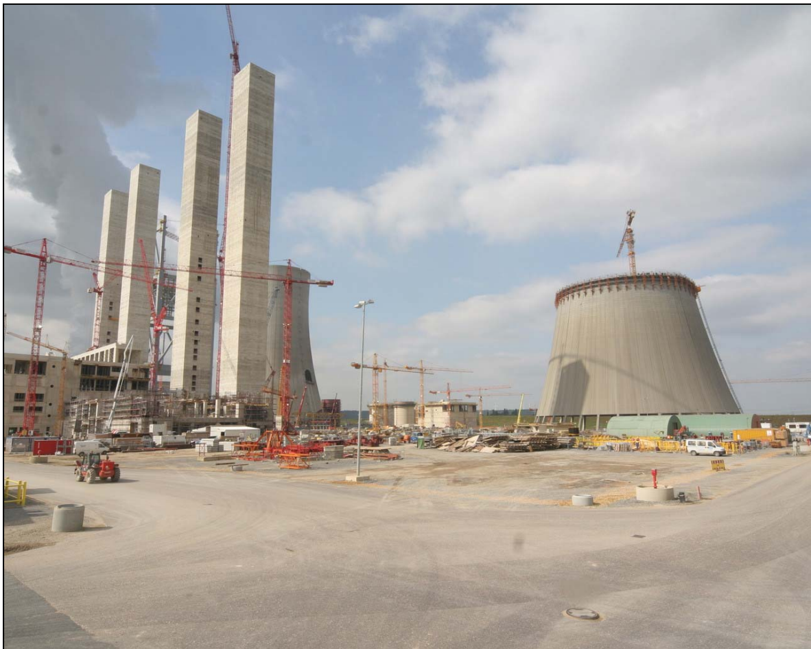
Blick auf die Baustelle
