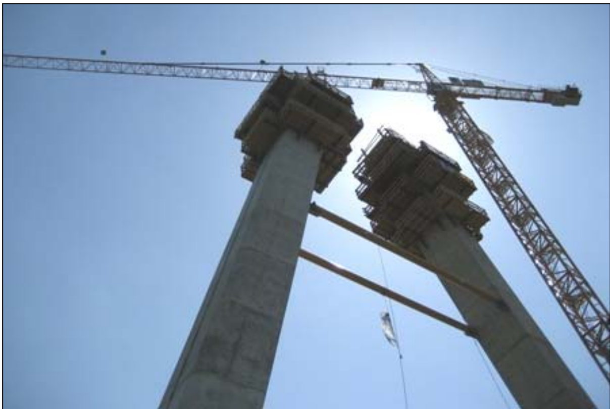
Pylon mit Kran
