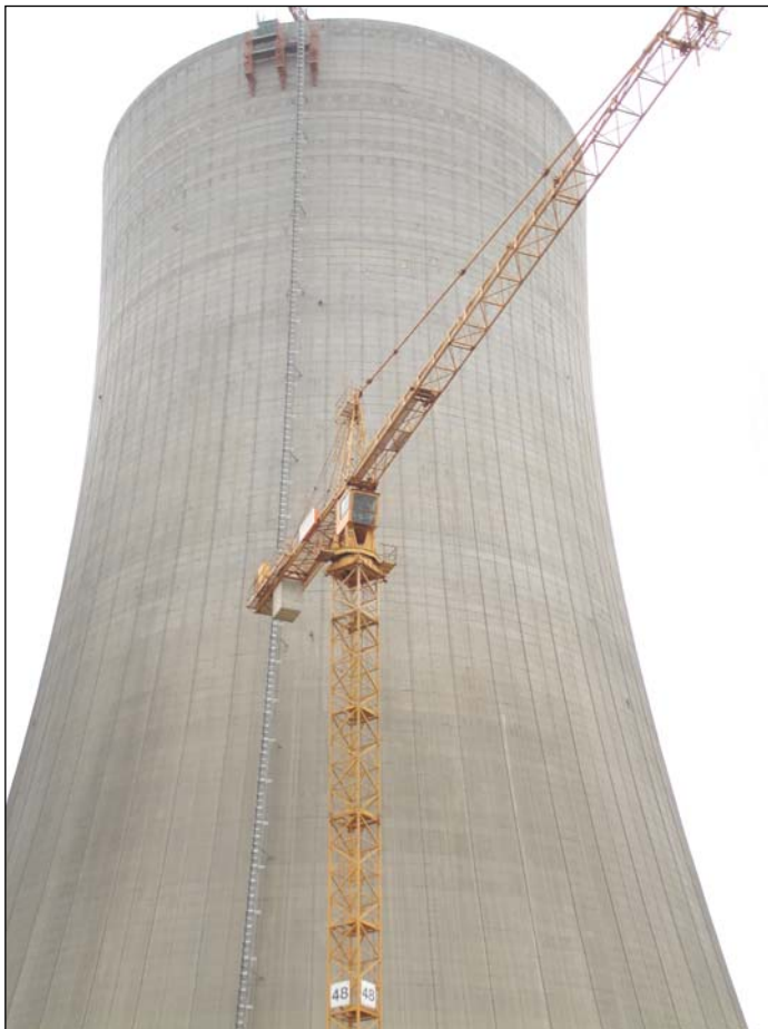
Herstellung eines Kühlturmes
