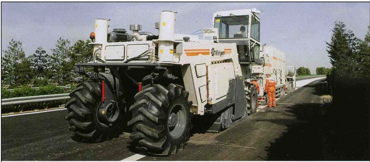
Kaltrecycler WR 2500 im Einsatz
