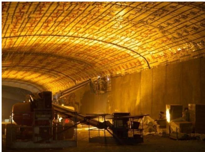
*Abb. 7: Innenausbau mit Fertigteilen und Spritzbeton*
