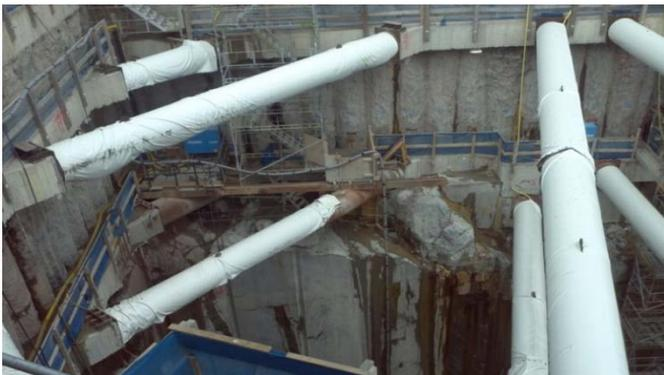
Abb. 9: Bohrpfehlwand im Fels eingebunden
