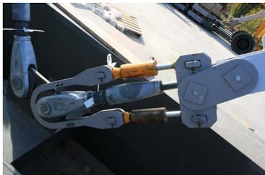
*Abb. 5: Spannring, zum Spannen und genauen Ausrichten der Stahlseile*
