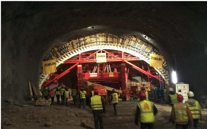
*Abb. 6: Betonierungsanlage für den Tunnelvortrieb*
