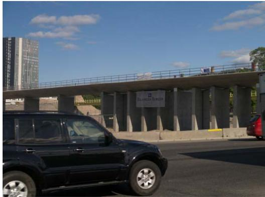
*Abb. 5: Eisenbahnbrücke mit Blindpfeilern*
