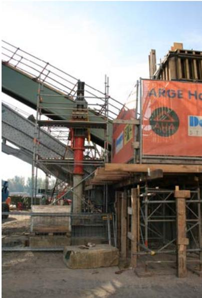
*Abb. 2: genietete Originalträger (unten), darüber neue Stahlträger, die die gesamte Verkehrslast aufnehmen*
