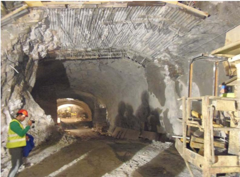
*Abb. 4: Problemstelle SS1 - orthogonal kreuzender Abwasserkanal*
