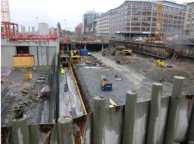
*Abb. 4: Bau der Tiefgarage direkt neben bestehender Bebauung*
