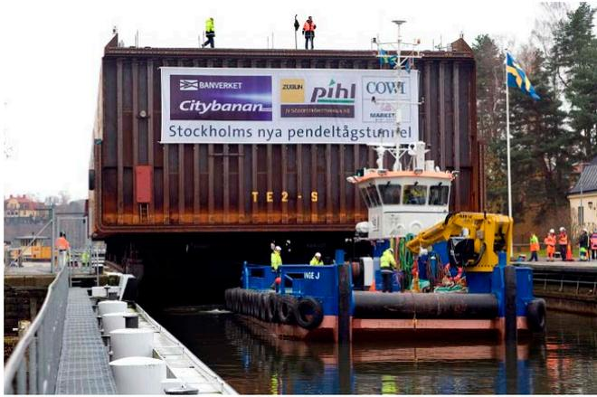
Abb. 11: Tunnel auf Ponton in Schleuse
