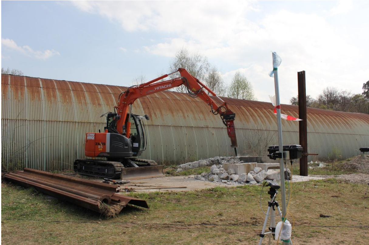
Abbildung 28: Versuchsreihe mit Hydraulikbagger und Immissionserfassungssystem (rechts)
