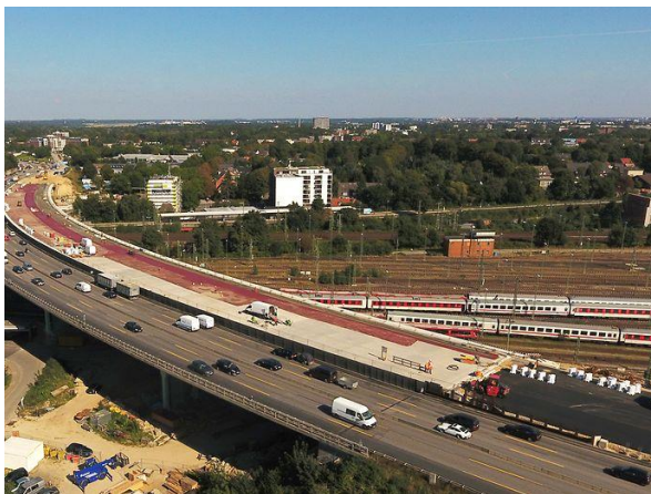
Abb. 4 Aufbringen des Ortbetons und der Fahrbahndecke 4
