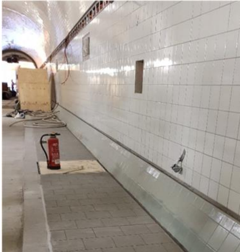
Abb.4: Gehweg, Tunnelwand (eigene Aufnahme)
