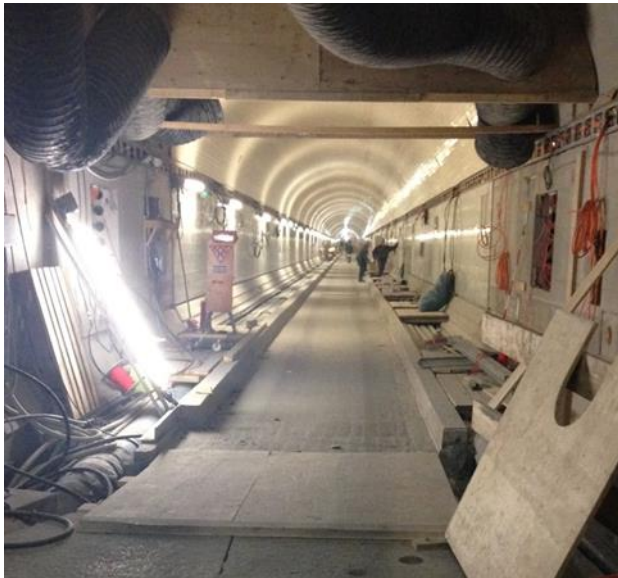
Abb. 1: Oströhre Elbtunnel, Innenausbau (eigene Aufnahme)
