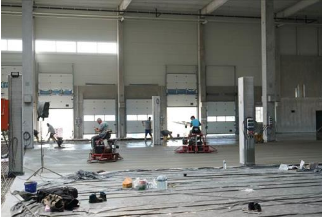
Abb.4: Glätten der frisch betonierten Bodenplatte (eigene Aufnahme)
