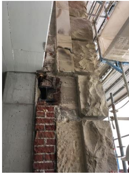
Abb.3: (von rechts) denkmalgeschützte Fassade, alte Mauerziegelwand, neue Betonwand (eigene Aufnahme)
