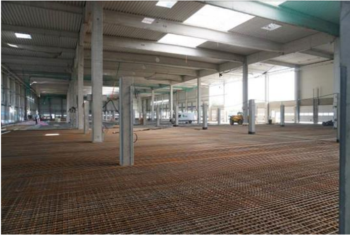
Abb. 5: Bewehrung der Bodenplatte im Ostteil der Halle (eigene Aufnahme)
