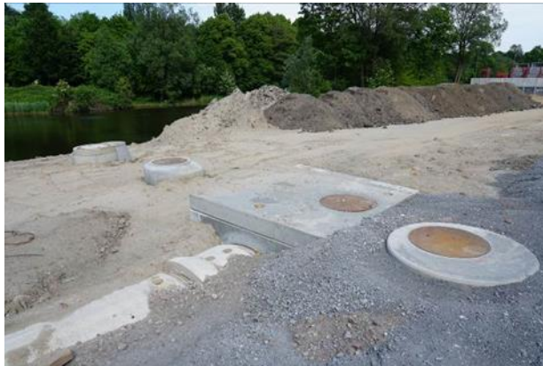
Abb.3: Die Geländeoberfläche wird komplett versiegelt; Entwässerung des Geländes durch Rohrleitungen in Richtung der Bille, damit Wasser nicht in die kontaminierten Bodenschichten eindringen kann (eigene Aufnahme)
