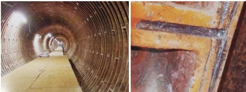
Abb.2 & 3: Tübbinge, Bleifugen (eigene Aufnahme aus Dokumentationsbuch von Herr Braatz)
