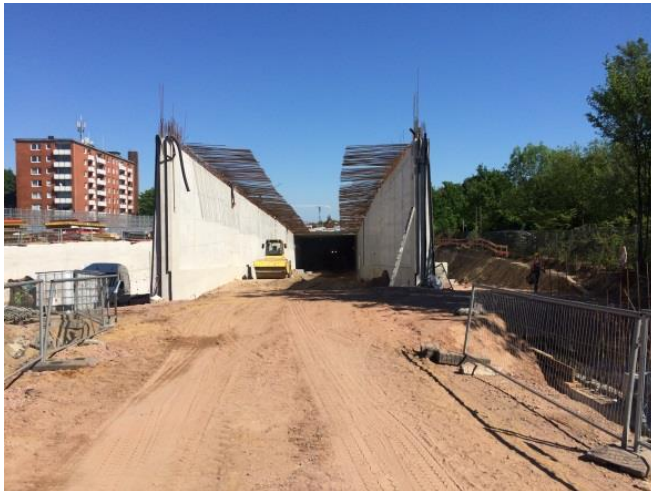
Abb. 5 Eingang des Tunnels (eigene Aufnahme)
