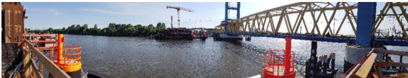
Abb. 1: Panorama der Baustelle, rechts die alte Kattwyk-Brücke (eigene Aufnahme)
