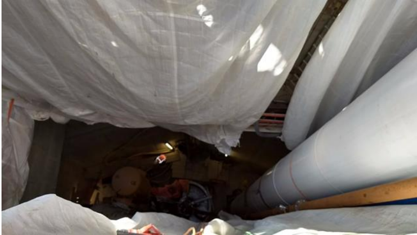
Abb. 5: Blick in den Senkkasten Materialschleuse (rechts) (eigene Aufnahme)
