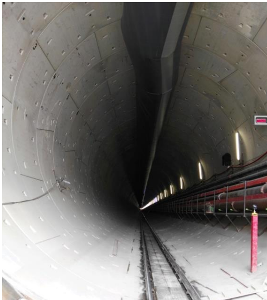
Abbildung 38: Baustellenbesichtigung Weströhre (eigene Aufnahme)
