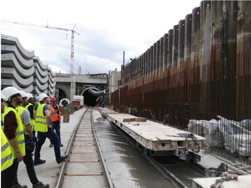
Abbildung 37: Baustellenbesichtigung Trog Nord
