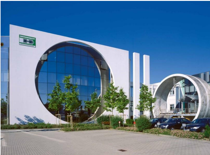
Abbildung 35: Blick auf Hauptoffice der Firma Herrenknecht 45
