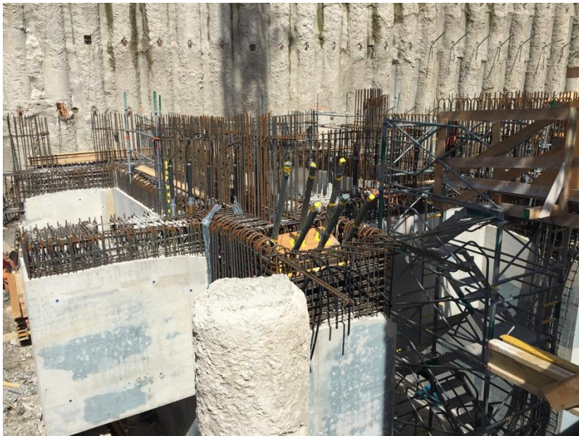
Abbildung 21: Stahlbeton Stützen mit Spannbeton zur Verankerung der auskragenden Häuser (eigene Aufnahme)
