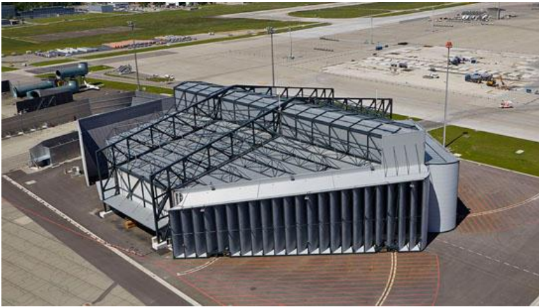
Abbildung 17: Die Schallschutzhalle am Flughafen Zürich 21
