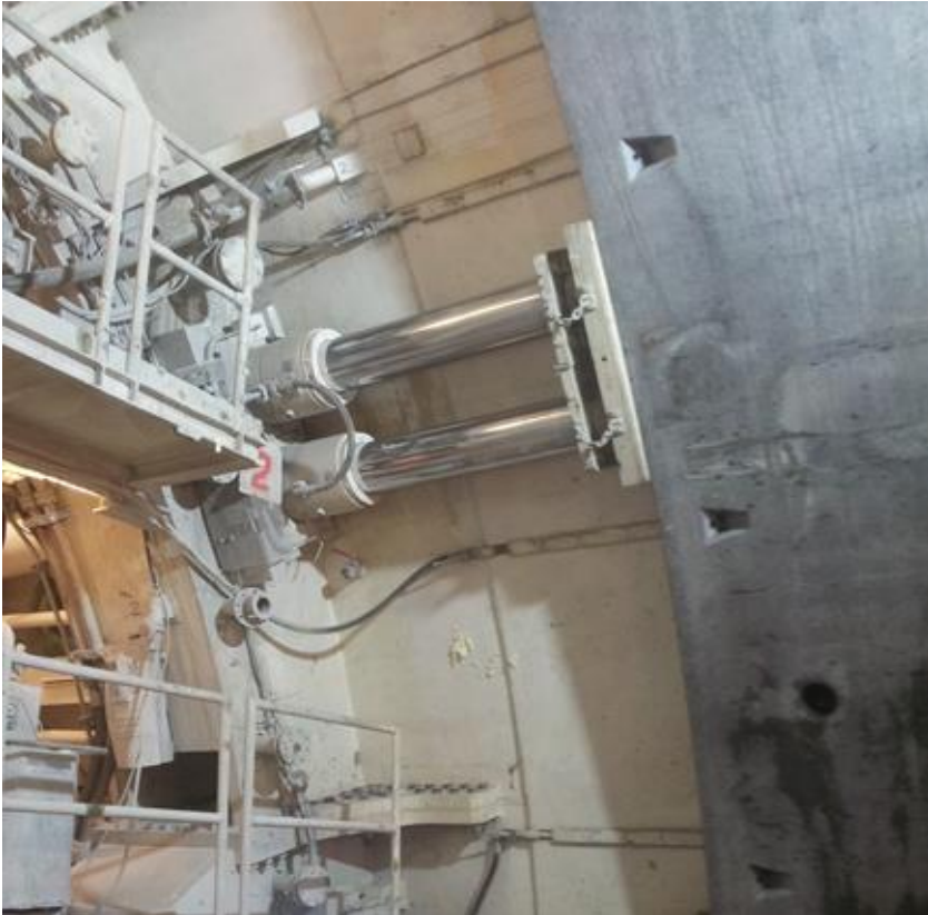
Abbildung 12: Hydraulikzylinder für den Vortrieb (eigene Aufnahme)
