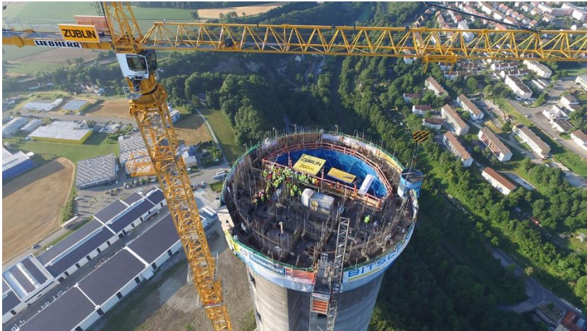
Abbildung 7: Gleitschalungen ThyssenKrupp Testturm
