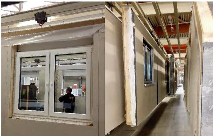
*Abb. 4: Einbau der Fenster und Türen<sup>5</sup>*
