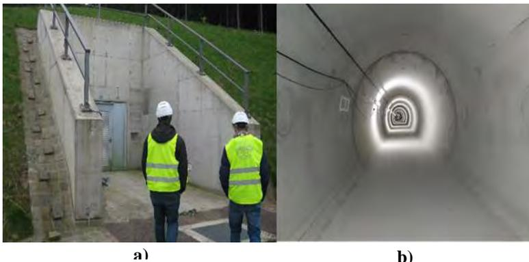
Abbildung 13: a) Konzept des Notausgangs<sup>21</sup>; b) Notausgang vom Silberbergtunnel, eigene Fotoaufnahme
