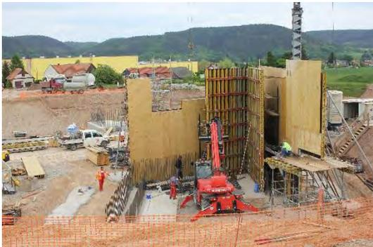
*Abb. 8: Schal- und Bewehrungsarbeiten am Bauwerk 2.2*
