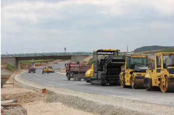
*Abb. 10: Baumaschinen zum Einbau des Straßenoberbaus mit dem Brückenbauwerk 2.10 im Hintergrund*
