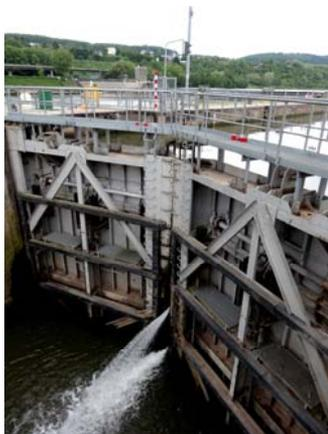
*Abb. 5: Bestands-Stemmtor mit Hydraulikzylindern (als Riegeltor ausgeführt)*
