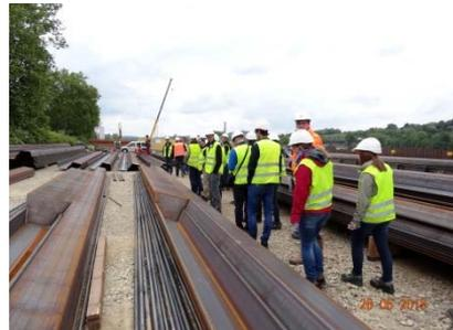
*Spundbohlenzwischenlager Bohlen mit angeschweißtem Rammerschutz gegen Schiffanprall auf Höhe der Wasserlinie*
