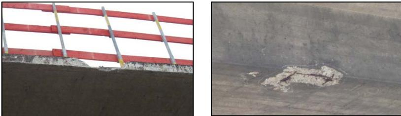
*Abb. 2: Betonabplatzungen am Randbereich (linkes Foto) und an der Unterseite des Überbaus (rechtes Foto)*
