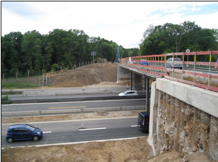
Abb. 4: Standort des (abgerissenen) südlichen Brückenteils, mit verbliebenen Fundamenten der Pfeiler zwischen den Fahrspuren der L124
