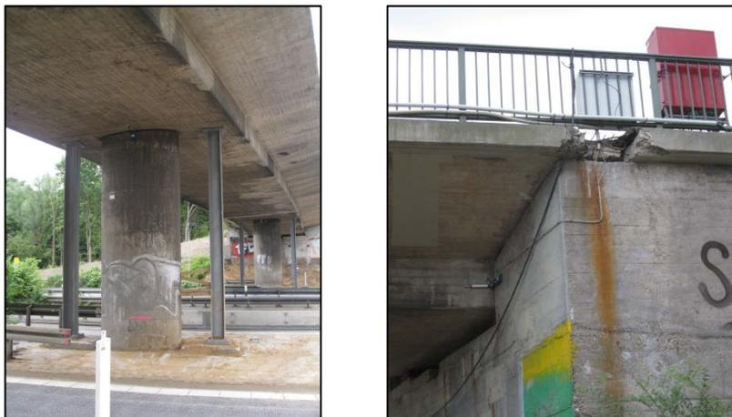
*Abb. 3: Stahlträger neben Betonpfeiler (linkes Foto) und Monitoring-Einrichtung (rechtes Foto)*
