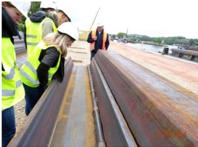
*Spundbohlenzwischenlager: Angeschweißte Rohrleitung zum Verpressen der Bohlen nach dem Einrütteln*
