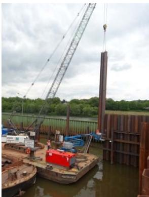
*Spundbohlen werden mit dem Seilkran vom Ponton eingehoben und anschließend eingetrieben.*
