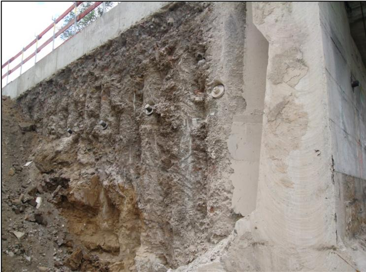
*Abb. 7: Stützende Bohrpfehlwand mit Verankerungen des Widerlagers*
