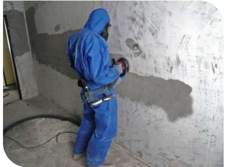
Ausgangslage: Spachtelmasse von Betonuntergrund abschleifen (nicht emissionsarmes Verfahren)
