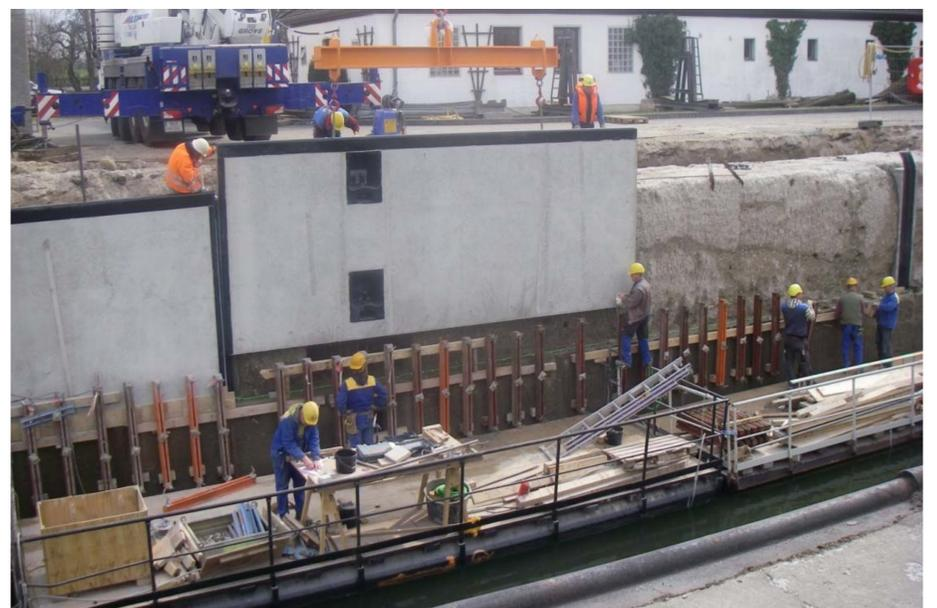
Abb. 2: Reprofilierung Schleuse Wedtlenstedt durch Fertigteile (BAW)
