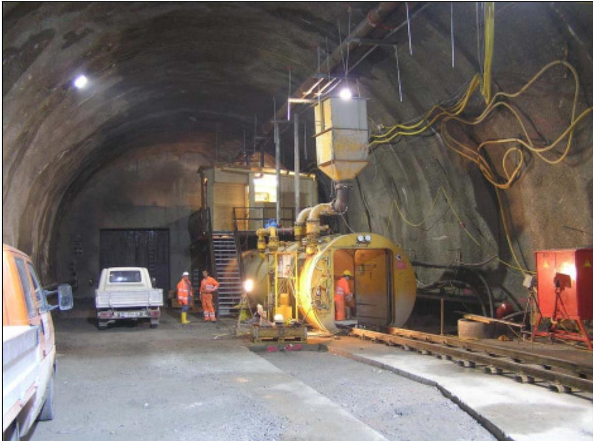
*Blick auf die Druckkammer: oben im Schuppen Personenschleuse, unten Materialschleuse*
