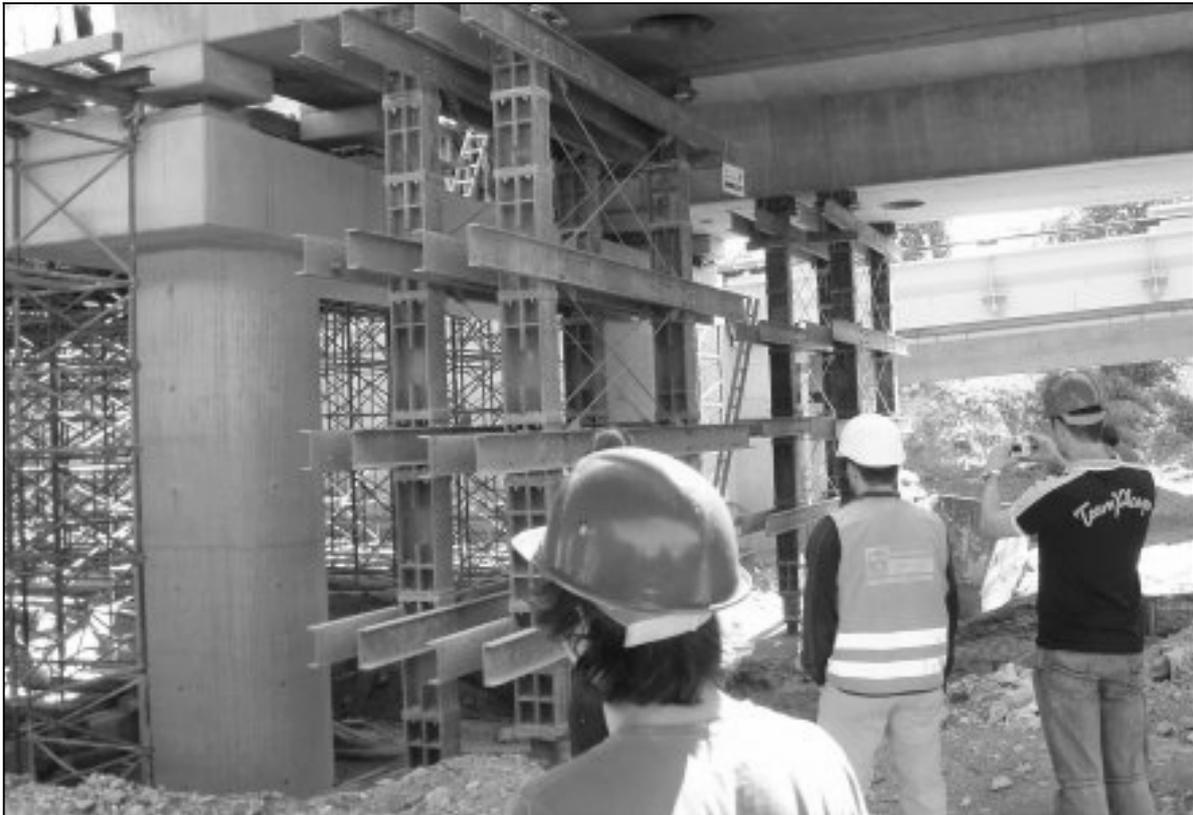
*Stahlstützen mit Hydraulikpressen*
