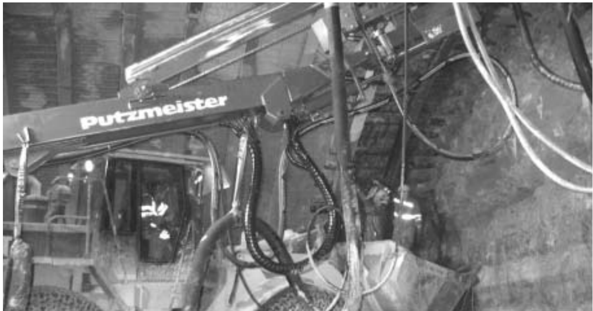
Putzmeister-Pumpen im Tunnelbau
