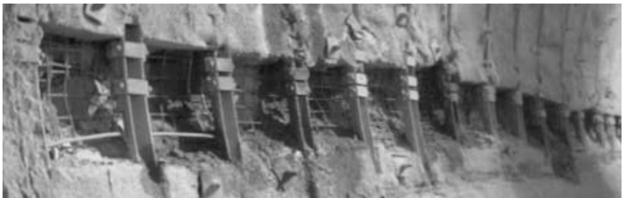
Flexibler Stahleinbau mit Deformationsstreifen
