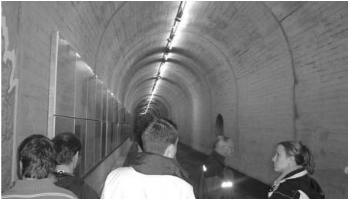
Der Zugangsstollen zum Kraftwerk
