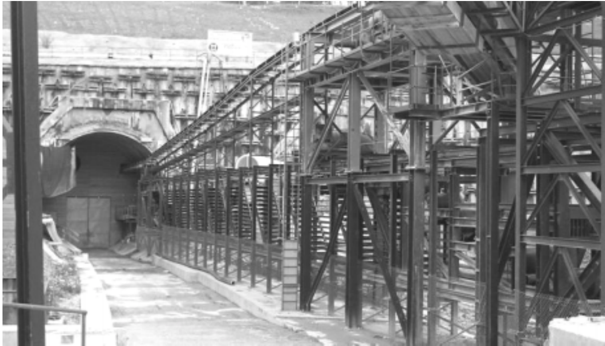
Förderbandanlage mit Bandvorhaltung am Südportal
