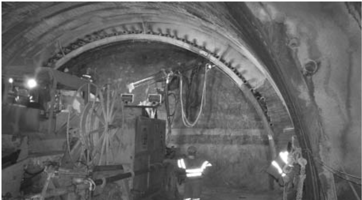
Vortrieb der Kalotte in der Bergöhre im Rohrschirmverfahren
