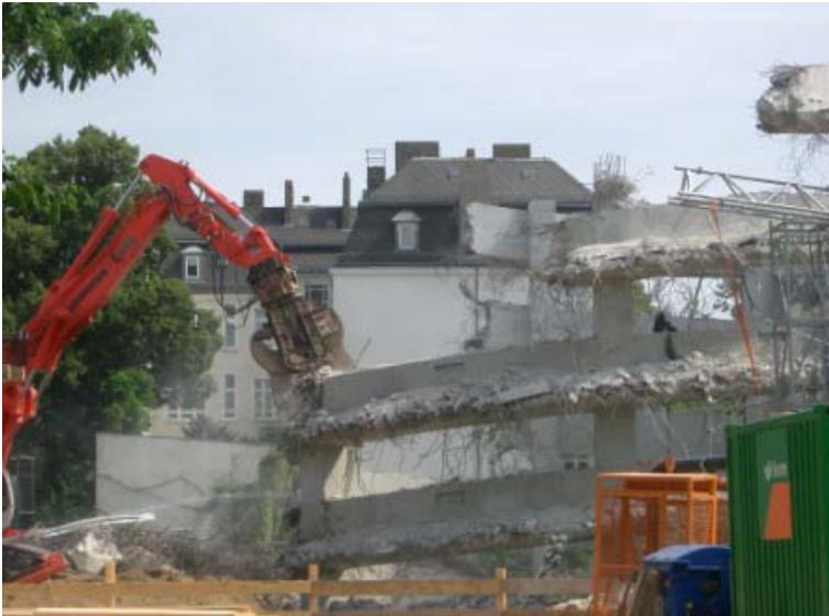
*Abb. 4: Abriss der alten Spindel via Betonschere*
