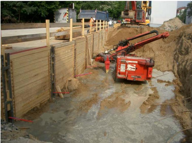
*Abb. 5: Baugrubensicherung durch Trägerbohlwand (Berliner Verbau),
