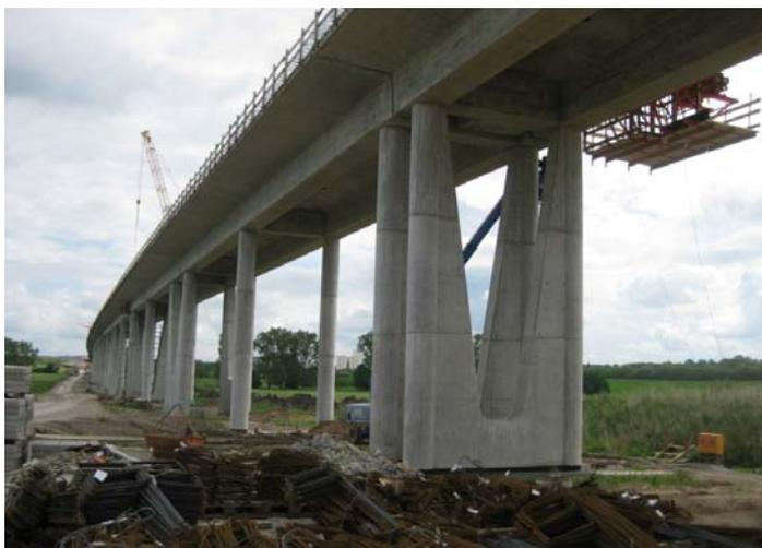
*Abb. 3: Pfeilerkonstruktion (Trennpfeiler, Normalpfeiler und Bremspfeiler)*
