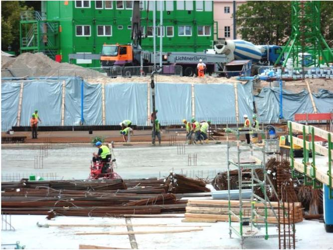
*Abb. 5: Betonieren der Bodenplatte*
