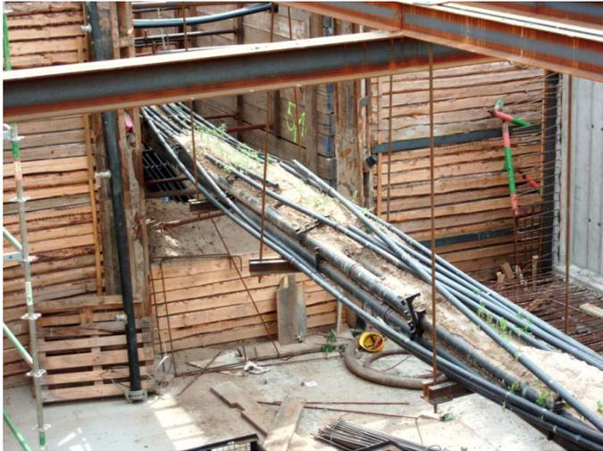
*Abb. 6: Durchführung der Telefonleitung über die Baustelle*
