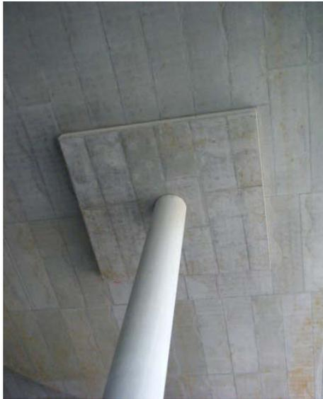
*Abb. 3: Stütze mit Stützkopfverstärkung*
