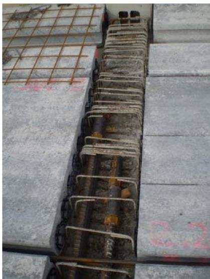
*Abb. 5: Zusätzliche Bewehrungsseisen (Durchmesser 40 mm)*
