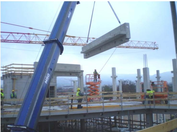
*Abb. 4: Einbau eines Stahlbetonriegels*
