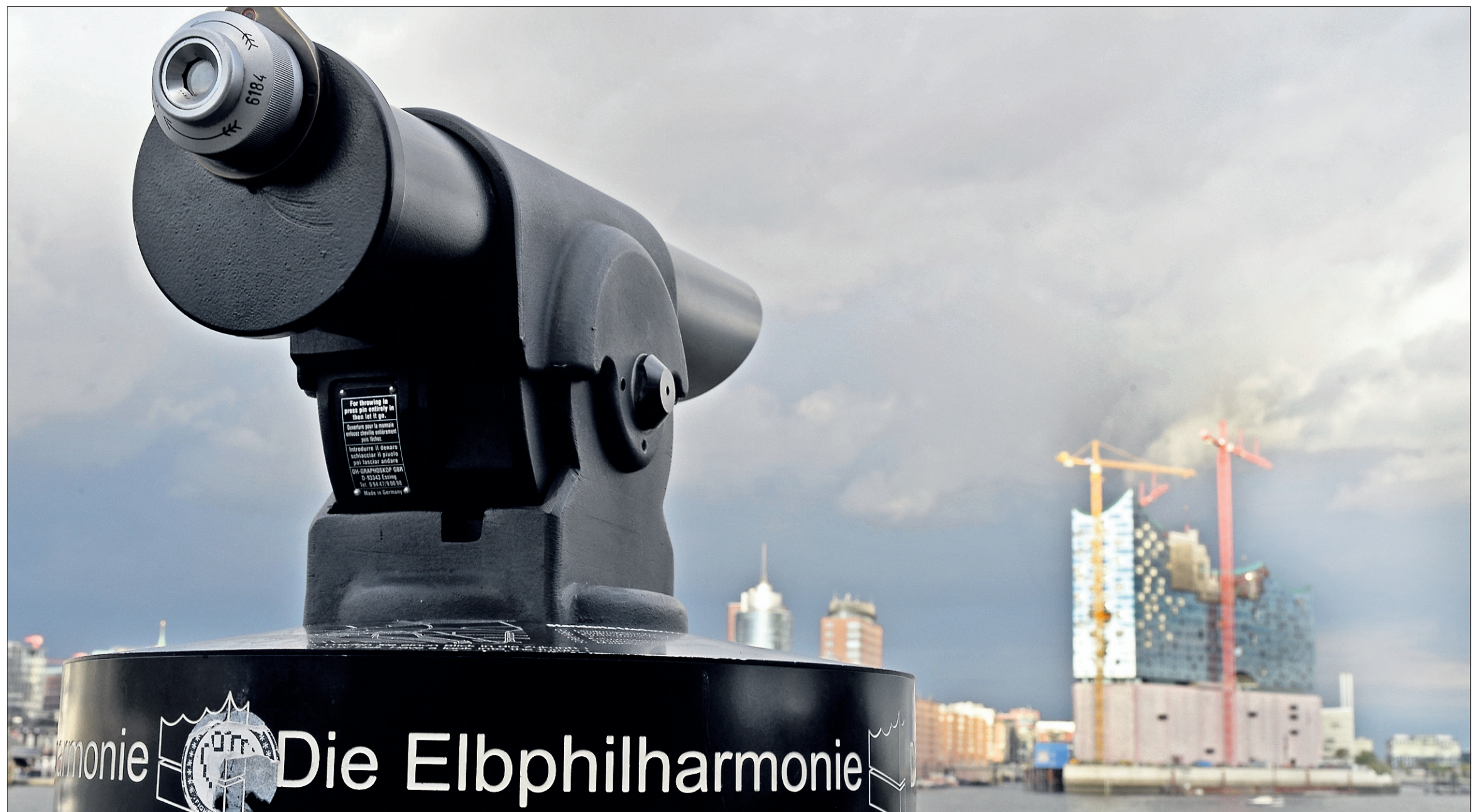
Ein Ende der Bauarbeiten deutet sich in der Ferne an: Im Frühjahr 2017 soll die Elbphilharmonie eröffnet werden – der ursprüngliche Eröffnungstermin verstrich im Herbst 2010.
