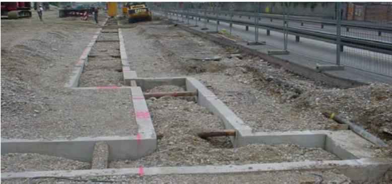
Abb. 10: Leitwände für den Schlitzwandgreifer<sup>11</sup>
