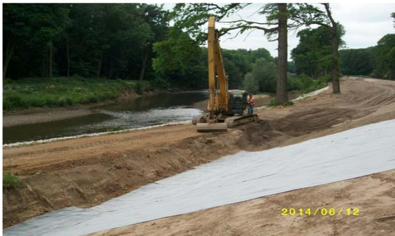
*Abb. 3: Aufschüttung des Damms<sup>7</sup>*
