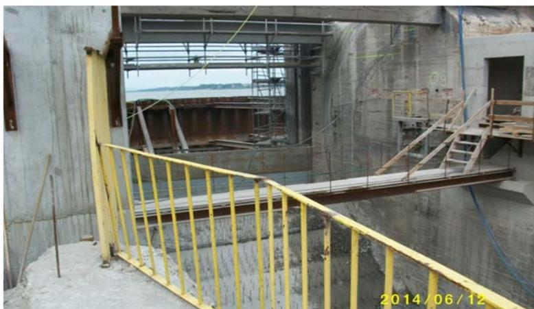
*Abb. 5: Ablassbauwerk mit Spundwand im Hintergrund<sup>9</sup>*
