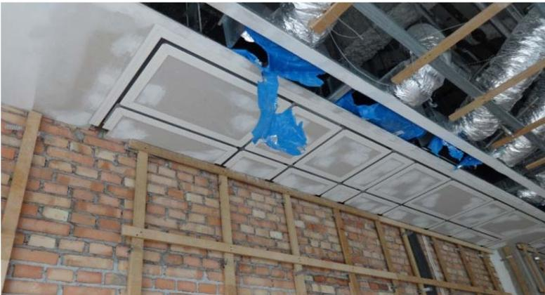
*Abb. 9: Deckenunterkonstruktion und Wandführungssystem<sup>10</sup>*
