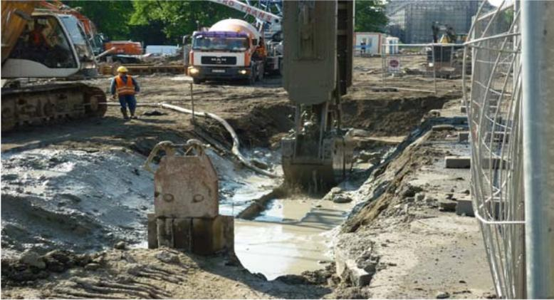
Abb. 9: Herstellung der Schlitzwand mit Greifer<sup>10</sup>
