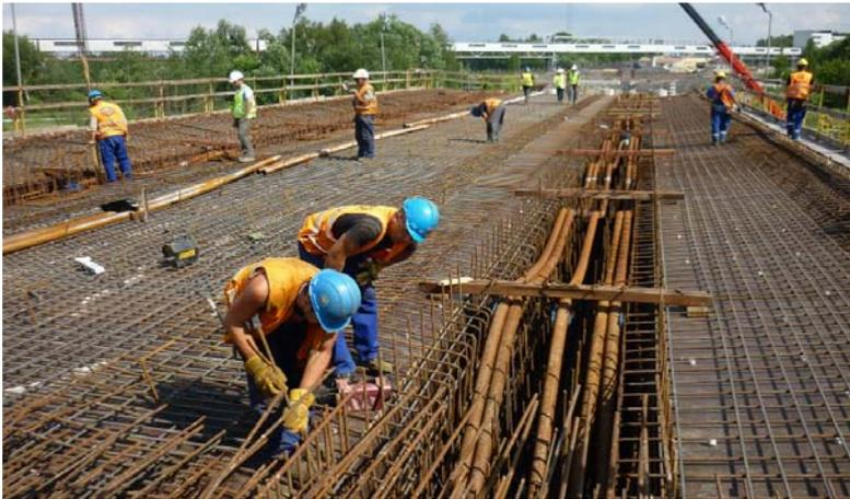
*Abb. 3: Bewehrung und Leerrohre<sup>3</sup>*
