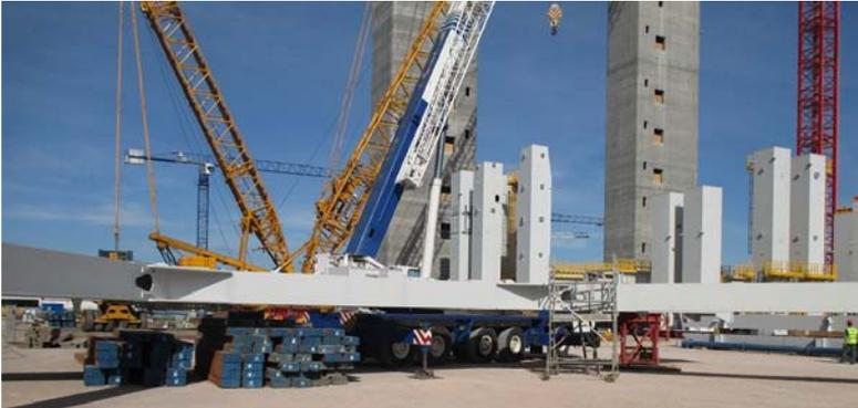
Abb. 3: Vormontage mit zusammengesetzter Stahlkonstruktion<sup>5</sup>
