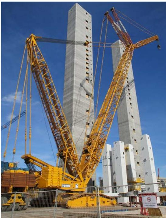
Abb. 4: Raupenkran zur Montage des Kesselgerüsts<sup>7</sup>
