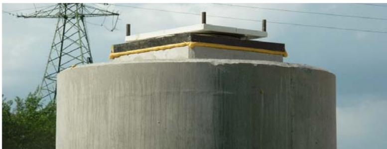
*Abb. 5: Topflager im Detail<sup>6</sup>*
