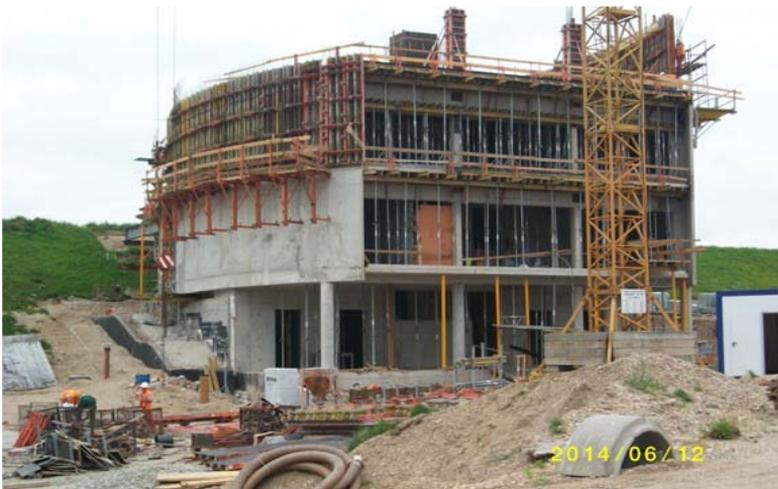
Abb. 7: Ablassbauwerk mit Arbeitsraum<sup>11</sup>
