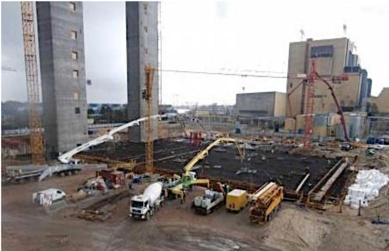
*Abb. 5: Betonage der Gründung<sup>9</sup>*
